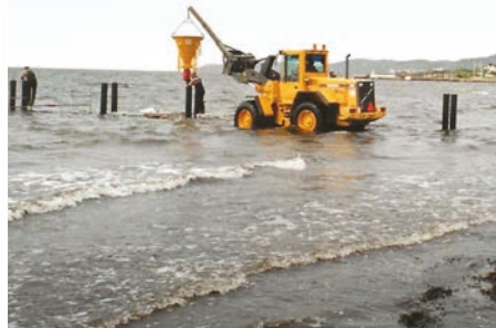
2001. Betong fylls i de sex meter höga pålarna. Invigningen av badbryggan den 20 juni 2001 var både festlig och välbesökt! Foton: Jan Malmberg
