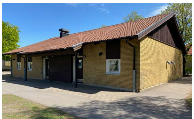
Miniplugget på Nyhamnsskolan, intill multiarenan, har två lektionssalar som på 48 timmar skall kunna ställas i ordning till skyddsrum.
