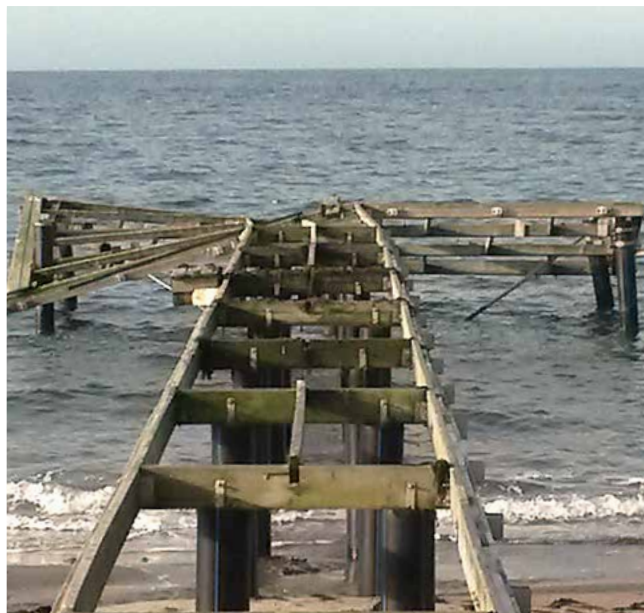
Trots att alla flakar och räcken tagits in för vintern, som brukligt är, skadades den yttre plattformen rejält. Foto: Axel Bergenfelt
