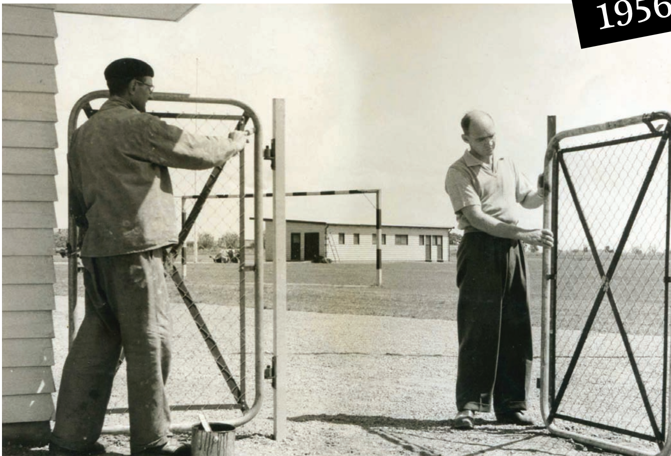
Vid ingången till idrottsplatsen från vänster Lars Roderman og Bo tillberg fisar det sista målningsarbetet före invigningen söndag den 17 juni 1956. Foto Gunnar Gunnarson
